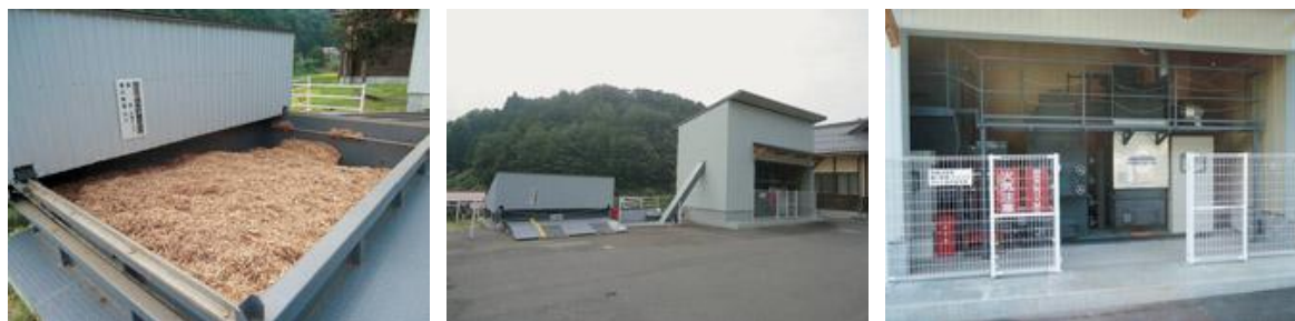
図 24 木質チップボイラー（満壽の湯）
